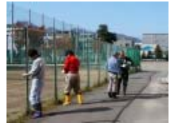
ネットフェンスの修理
